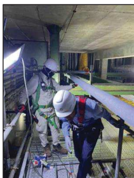
รูปที่ 3-66 การติดตั้งไฟส่องสว่างบริเวณพื้นที่ก่อสร้าง
