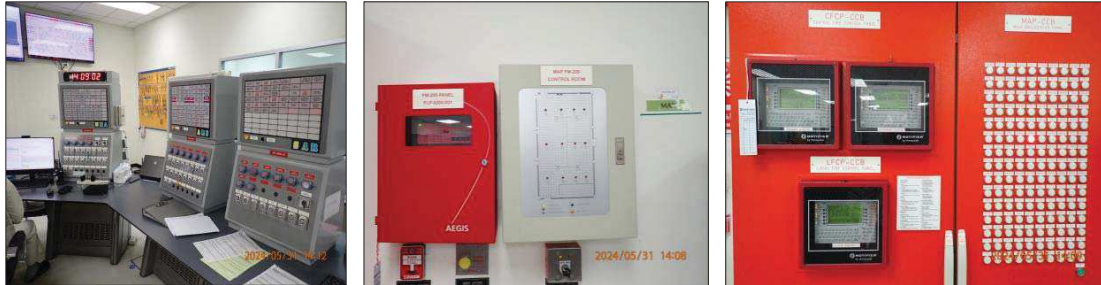
ตัวอย่าง Emergency shutdown system – ESD Control Panel ของ MMA Plant สามารถสั่งหยุดระบบกรณีพบการรั่วไหลได้ในห้องควบคุม
