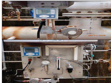
เครื่องตรวจวัด pH และ Conductivity บริเวณบ่อกักน้ำทิ้ง ขนาด 9,600 ลูกบาศก์เมตร
