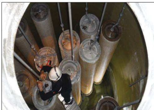
รูปที่ 3-5 การตรวจสอบ Demister ด้วยสายตาของปล่อง SAR ช่วงหยุดซ่อมบำรุง
