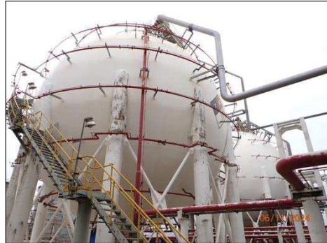
รูปที่ 3-40 ระบบดับเพลิงบริเวณถังแอมโมเนียและโพรเพน
