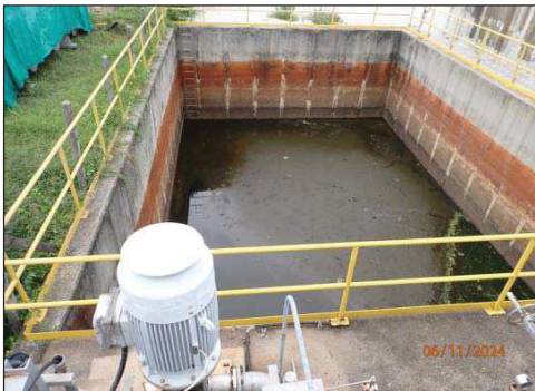
บ่อรวบรวมน้ำฝนปนเปื้อนบริเวณลานถัง
