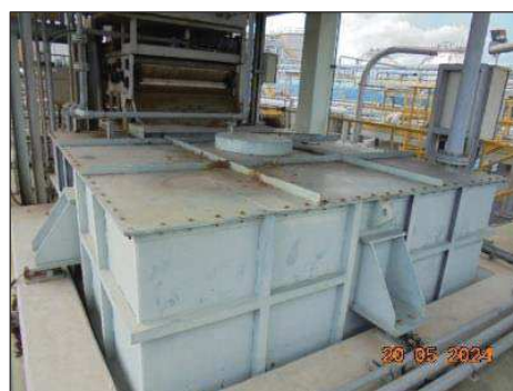
รูปที่ 3-18 จุดรวบรวมกากตะกอนจากระบบบำบัดน้ำเสีย
