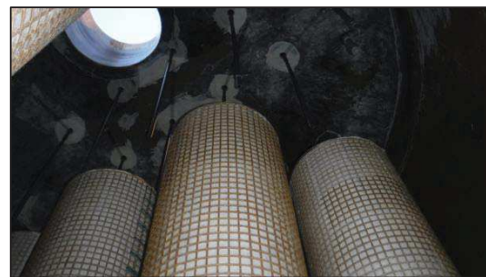
รูปที่ 3-5 การตรวจสอบ Demister ด้วยสายตาของปล่อง SAR ช่วงหยุดซ่อมบำรุง
