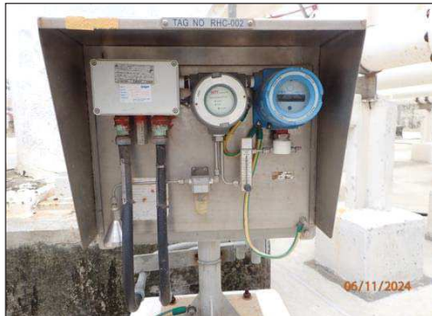
Gas Detector บริเวณถังเก็บกากโฟรเพน
