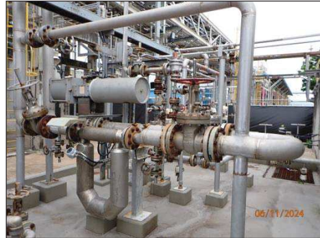
รูปที่ 3-34 Block Valve บริเวณท่อขนส่ง
