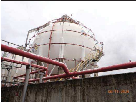
รูปที่ 3-40 ระบบดับเพลิงบริเวณถังแอมโมเนียและโพรเพน
