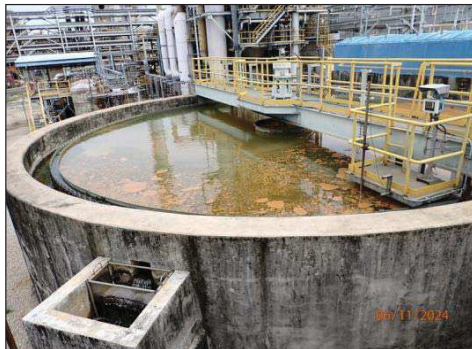
บ่อบำบัดน้ำทิ้งจากระบบบำบัดน้ำเสีย (RO-BIO)
