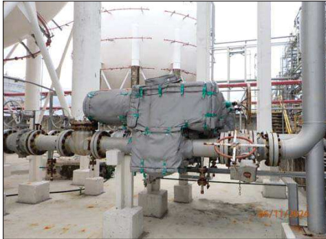
รูปที่ 3-34 Block Valve บริเวณท่อขนส่ง
