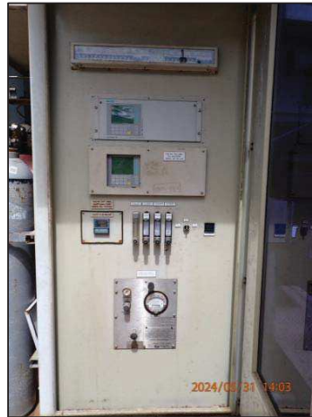
รูปที่ 3-4 เครื่องมือตรวจสอบคุณภาพอากาศจากปล่องแบบอัตโนมัติ (CEMS)
