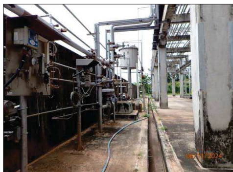
รูปที่ 3-12 ระบบรวบรวมน้ำฝนแยกจากระบบรวมน้ำเสีย
