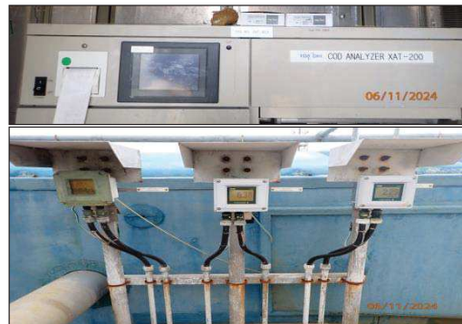
เครื่องตรวจวัด pH และ COD แบบอัตโนมัติ บริเวณบ่อบำบัดน้ำทิ้งจากระบบบำบัดน้ำเสีย (RO-BIO)
