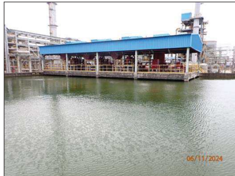
รูปที่ 3-42 บ่อน้ำสำรองดับเพลิง
