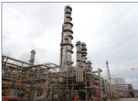
Wastewater Column จากหน่วยผลิต AN
