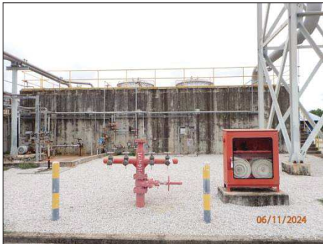
รูปที่ 3-41 บ่อรวบรวมและปรับสภาพ สารละลายแอมโมเนียมไฮดรอกไซด์ที่หกั่วไหล
