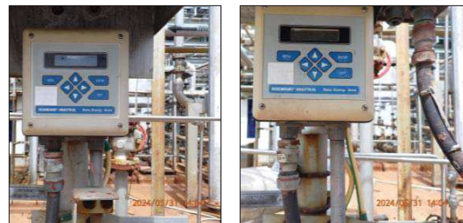
เครื่องตรวจวัด pH และ Conductivity แบบอัตโนมัติ บริเวณบ่อบำบัดน้ำทิ้งจากหน่วยผลิตกรดซัลฟูริก (SAR)
